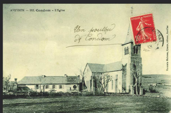
DÉBUT 20 e SIÈCLE - L'église entièrement reconstruite en 1892 et le presbytère
